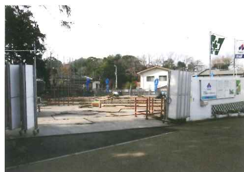
2018年12月 工事の様子
